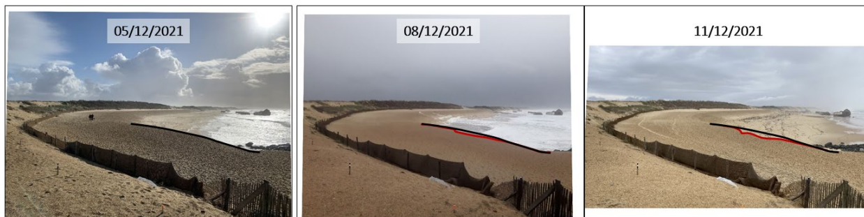
Figure 26 - Photos CoastSnap illustrant le recul de l'arrête du merlon, intervenu au début de l'hiver 2021-2022
