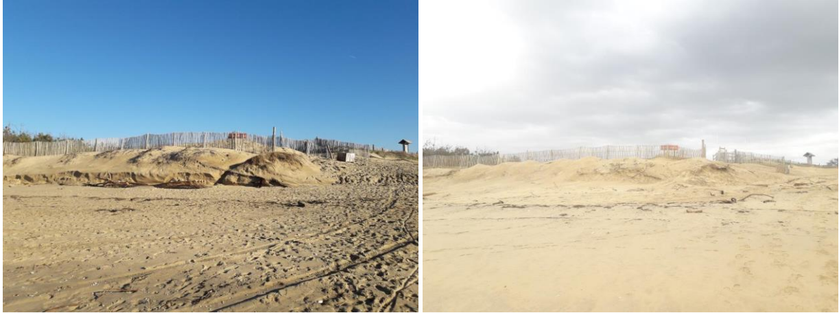
Figure 12 - Accès plage au droit du terminus du petit train le 05/12/2022 (gacuhe) et le 13/03/2023 (droite). © Observatoire de la côte de Nouvelle-Aquitaine
