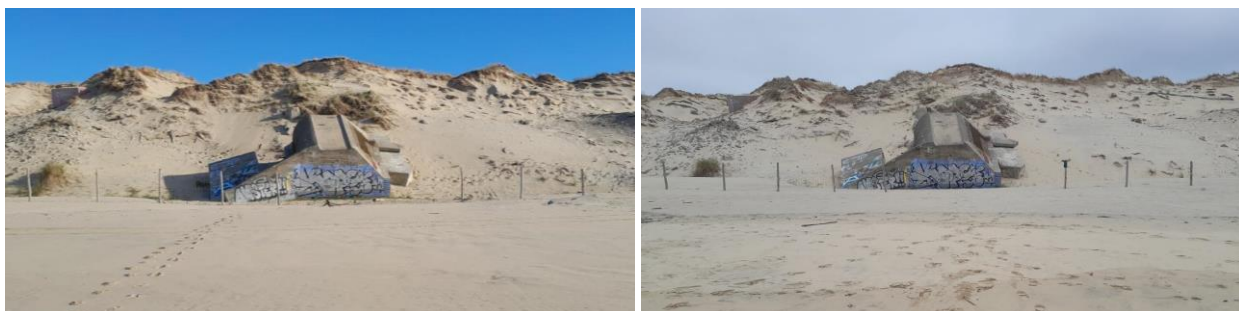
Figure 18 - Blockhaus de l'Alexandre au nord de Lacanau-Océan le 30/11/2022 (photo de gauche) et le 21/03/2023 (photo de droite). © Observatoire de la côte de Nouvelle-Aquitaine
