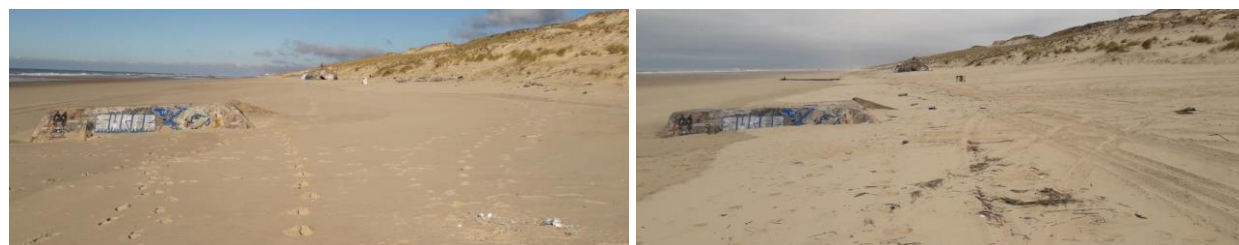
Figure 19 - Blockhaus du Lion au sud de Lacanau-Océan le 30/11/2022 (photo de gauche) et le 21/03/2023 (photo de droite). © Observatoire de la côte de Nouvelle-Aquitaine
