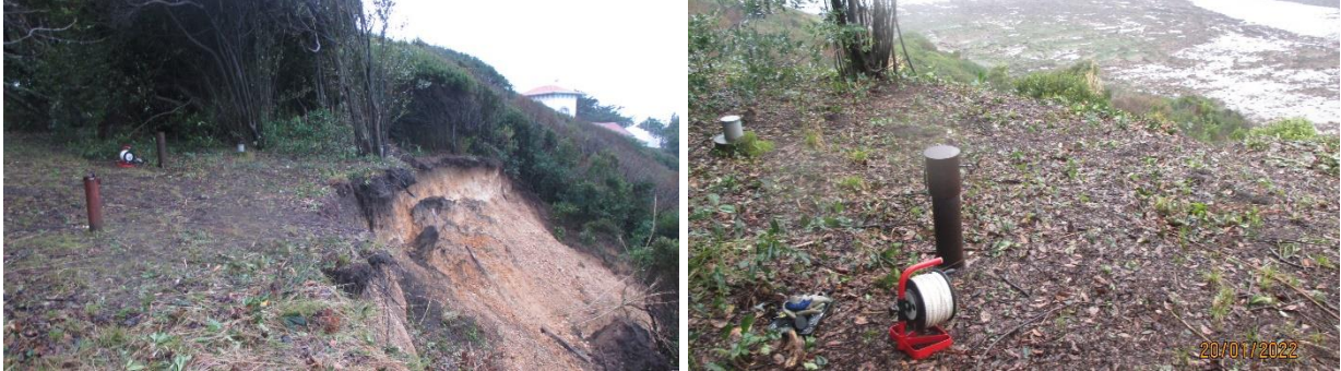
Figure 6 - Photos de l'ouvrage de Guéthary / la Muserie - P153 (BSS002HMDT) datées du 22/01/2022
