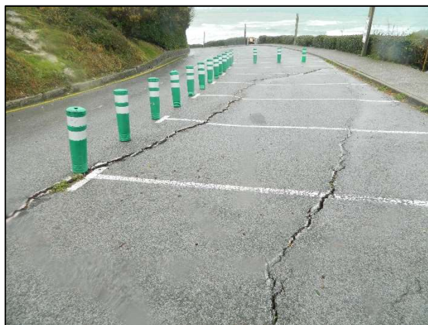
Figure 9 - Réactivation le 08/12/2020 et extension de l'emprise du glissement de terrain de la Rue de la plage (Bidart Centre) ; cliché 11/12/2020 (©Observatoire de la Côte Aquitaine, 2020)
