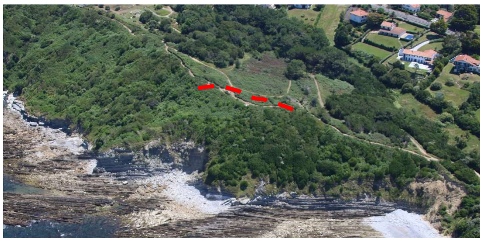
Figure 15 - Extension approximative de la surface concernée par les indices de mouvements, qui se sont déclarés le 10/12/2020, à l'ouest de la Croix d'Archilua à Saint-Jean-de-Luz (©Observatoire de la Côte Aquitaine, Olivier Chaldebas, ULM Sud Bassin, 2020)
