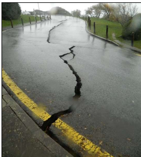
Figure 9 - Réactivation le 08/12/2020 et extension de l'emprise du glissement de terrain de la Rue de la plage (Bidart Centre) ; cliché 11/12/2020 (©Observatoire de la Côte Aquitaine, 2020)
