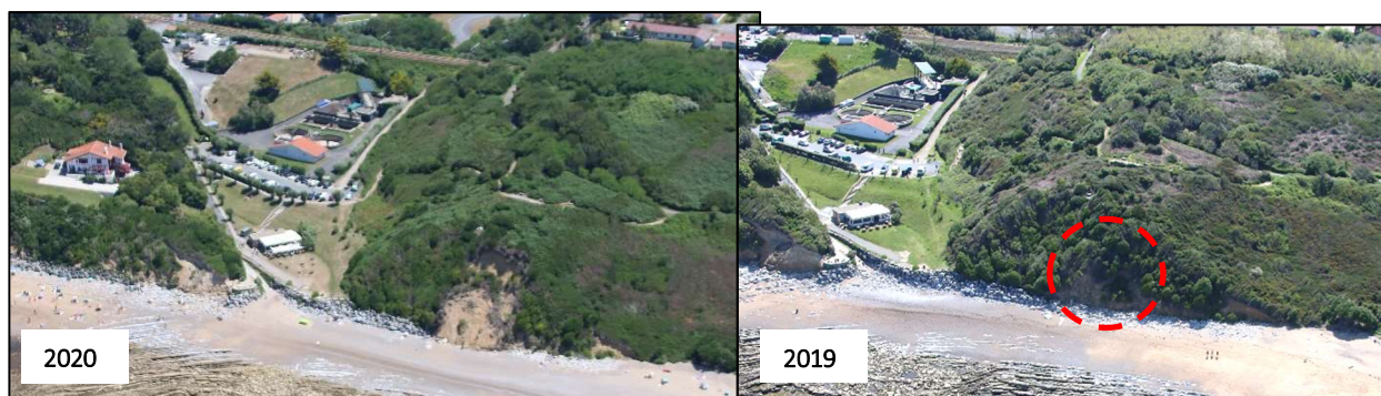
Figure 13 - Glissement des falaises, entre les campagnes photographiques de 2019 et 2020, dans le secteur de Cenitz (Guéthary) ; identification d'une zone active (©Observatoire de la Côte Aquitaine, Olivier Chaldebas, ULM Sud Bassin, 2019 et 2020)
