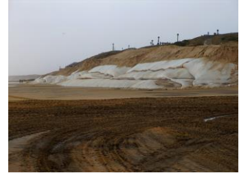
Biscarrosse - érosion plage février 2014 – photo ONF B. Duport
