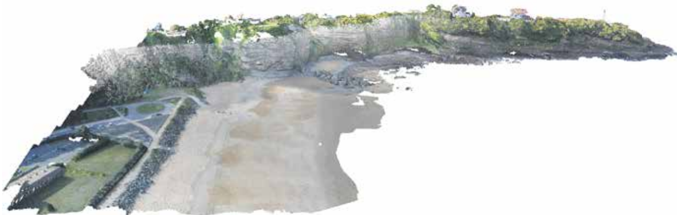
Figure 4. Modèle numérique de terrain obtenu par photogrammétrie d'image drone de la plage et de la falaise du Cap Saint-Martin (Anglet et Biarritz, Pyrénées-Atlantiques ; réalisation V. Marieu)
