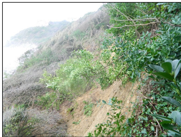
Figure 13 : Arrachement en tête du glissement de terrain de janvier 2021 (parcelle 215)
