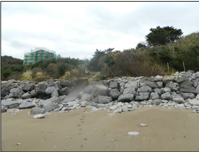
Figure 8 - Déformation de l'enrochement de haut de plage dû au glissement et impact des vagues en arrière de l'ouvrage
