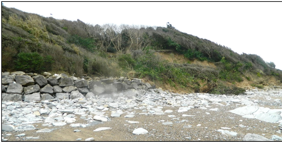
Figure 12 - Glissement de terrain, janvier 2021, survenu au droit de la parcelle 215
