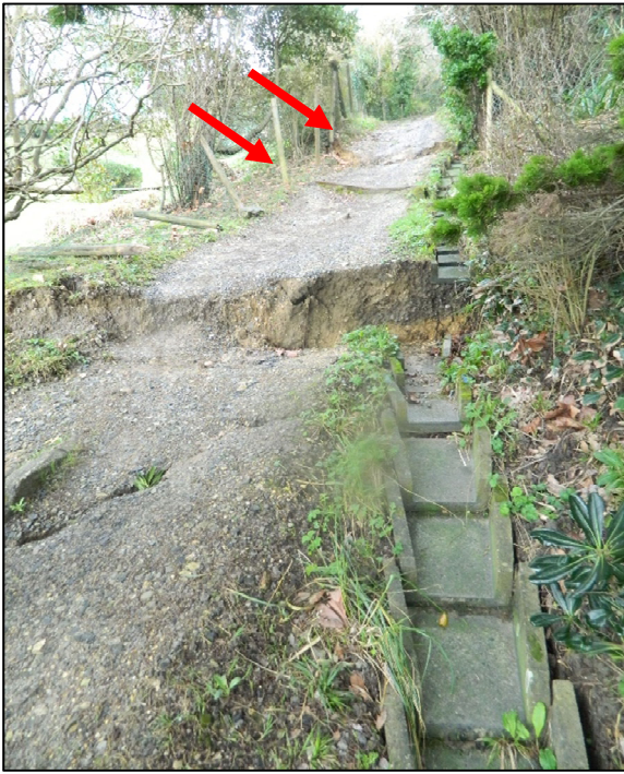
Figure 7 - Niches d'arrachement emboîtées au droit du chemin Harotzen Costa
