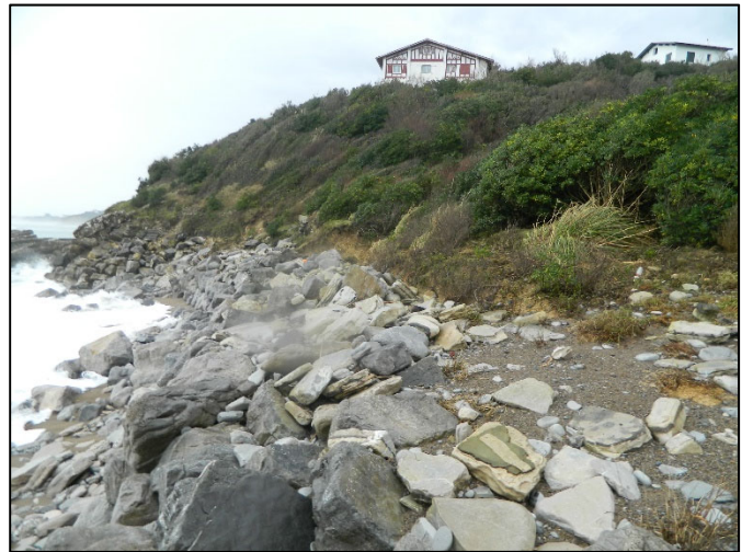
Figure 8 - Déformation de l'enrochement de haut de plage dû au glissement et impact des vagues en arrière de l'ouvrage
