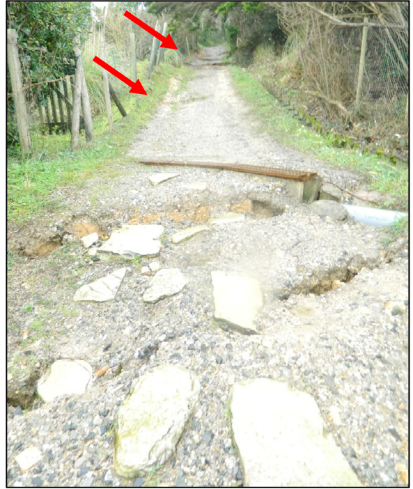
Figure 7 - Niches d'arrachement emboîtées au droit du chemin Harotzen Costa
